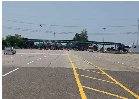
Maigalganj Toll Plaza
