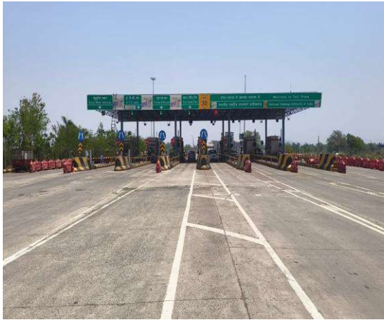
Mohtara Toll Plaza
