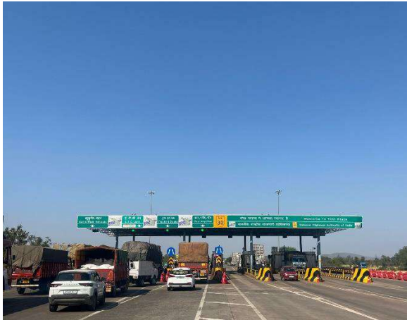
Mohtara Toll Plaza
