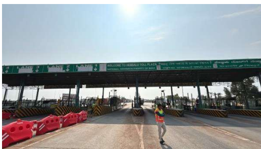
Hebbalu Toll Plaza
