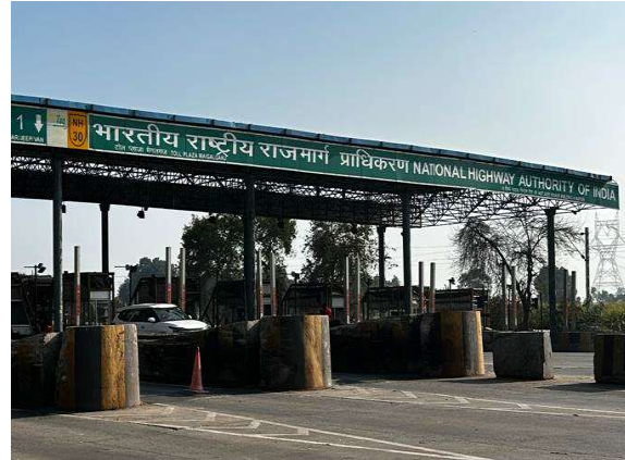
Maigalganj Toll Plaza
