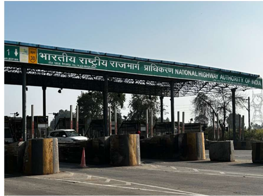
Maigalganj Toll Plaza
