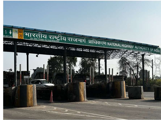
Maigalganj Toll Plaza
