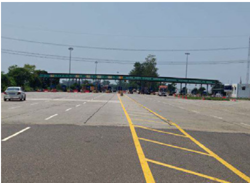
Maigalganj Toll Plaza
